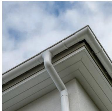
Bei Walmdächern mit Dachbinderkonstruktion erfolgt eine waagrechte Verschalung.
